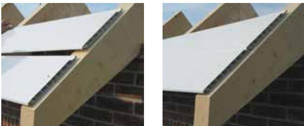
Folienbeschichtete Verkleidungsprofile müssen einen Dehnungsabstand von 15mm zu den Außenkanten der Zusatzprofile haben. Bei farbig beschichteten Verkleidungsprofilen ist es zwingend vorgeschrieben, mit Profilbrettklammern zu arbeiten, da sonst keine Gewährleistung auf das Produkt übernommen wird.
